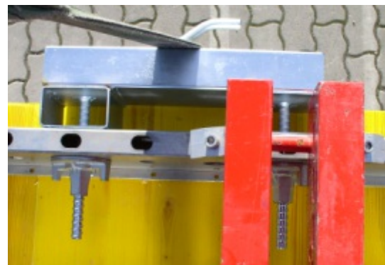
Sicherung der Ladehilfe mit zwei Flanschmuttern
