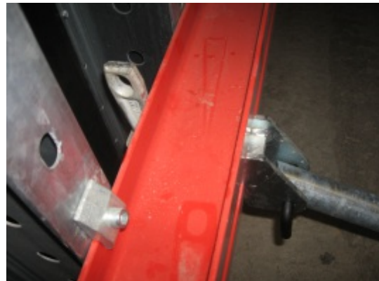
Befestigung des Richtkonsolenanschlusses mit Keil
