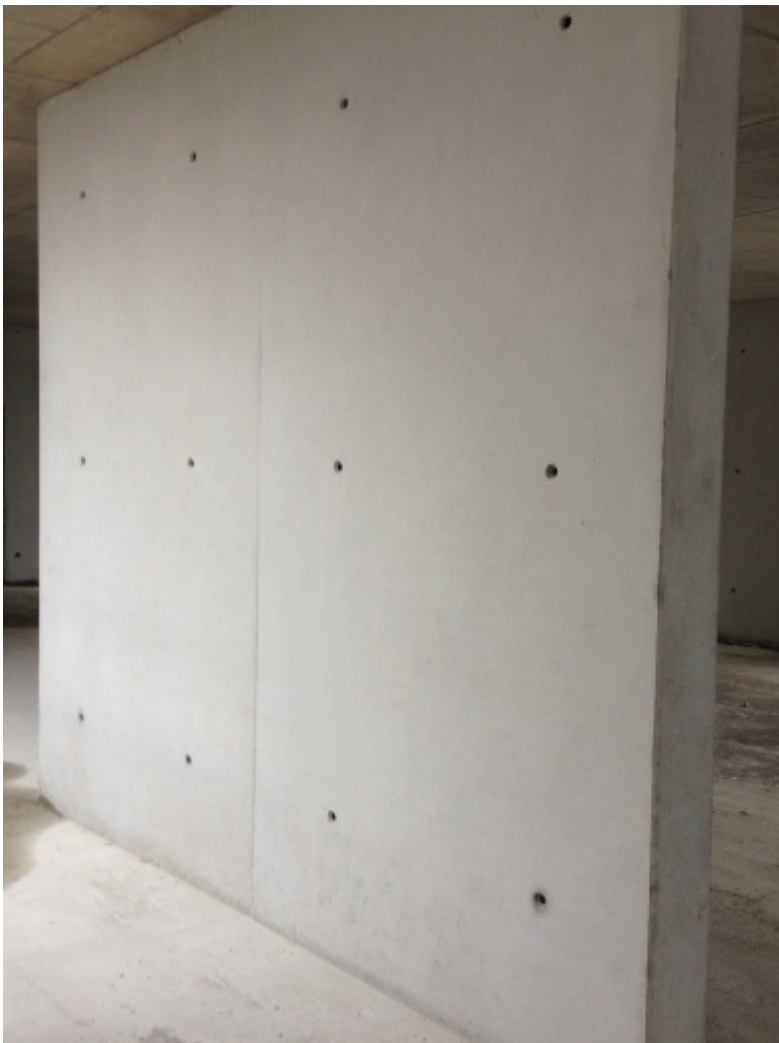
Optimale Fugenqualität durch Einsatz der PRIMAX-Differenzlasche
