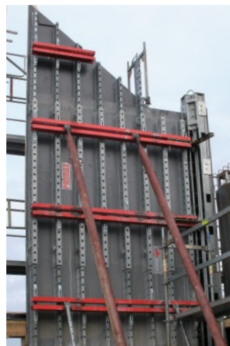
Exzenter drehen, danach Befestigung der Schalhaut
