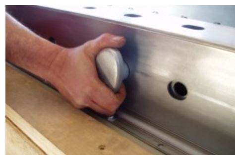
Exzenter drehen, danach Befestigung der Schalhaut
