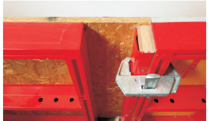
Restmaßausgleich mit Schalhaut-Zuschnitt
